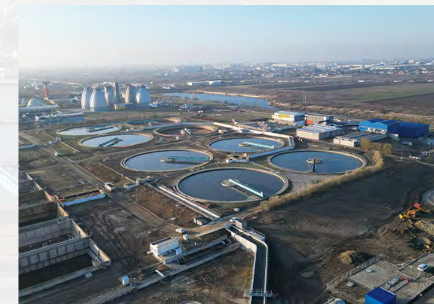
Decantadores de la EDAR de Glina, en Bucarest, Rumanía.
